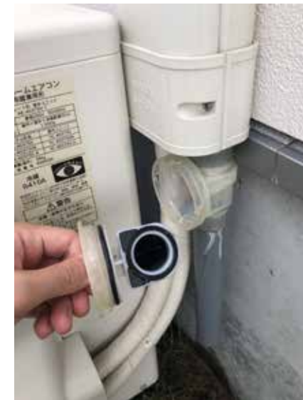
④排水トラップのキャップについた ゴムパッキン内部を確認する
