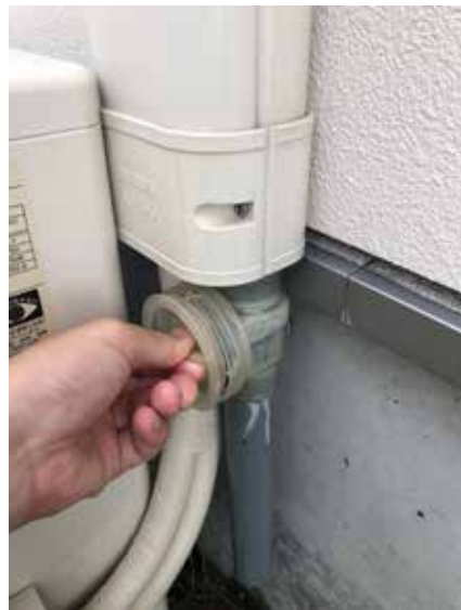
②排水トラップのキャップを 左に回す
