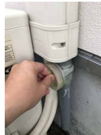
⑧排水トラップのキャップを元 に戻して完了
