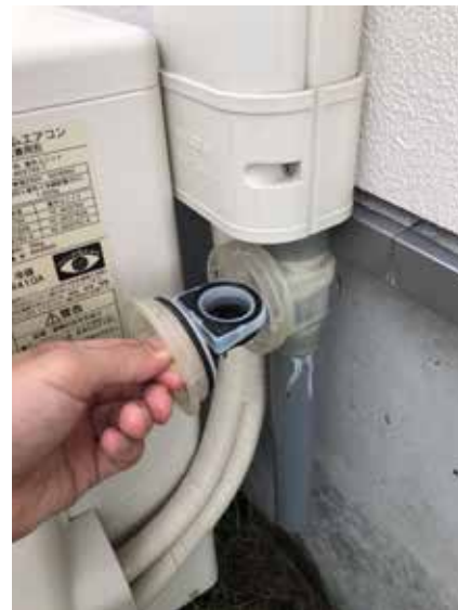
③排水トラップのキャップを 引き抜く
